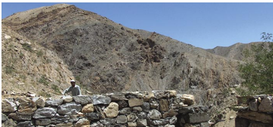
Mitt bland bergen byggdes en skola som ska stå färdig i november. Här ska hela 800 barn få en skola att gå till.
