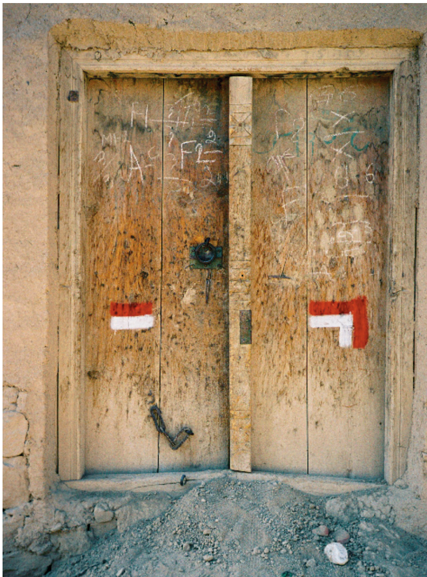
Rött streck över vitt indikerar att marken runt huset är minröjd, men att det ännu inte är röjt inne i huset.
