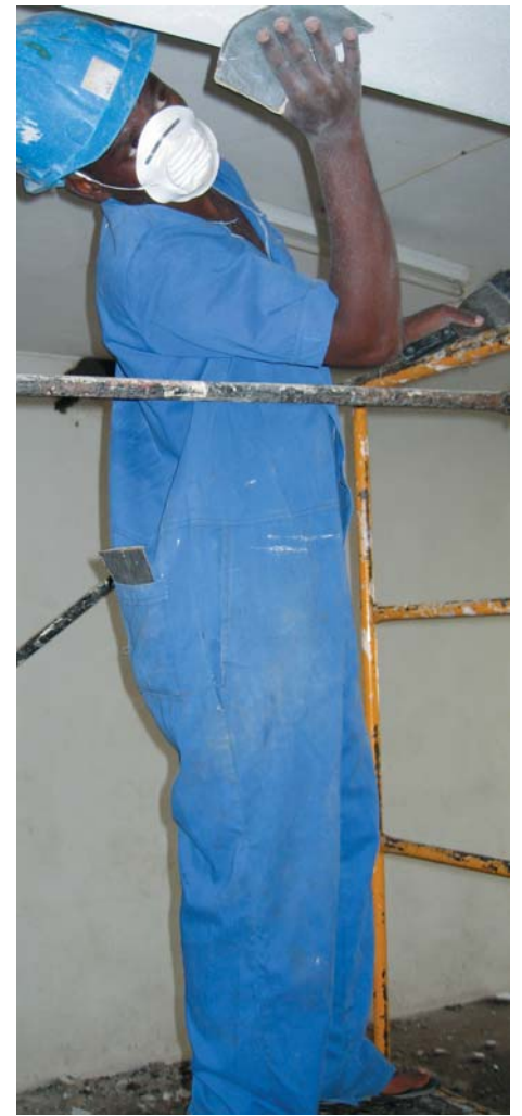
Hierarkin på arbetsplatsen är glasklar. Målarlär-lingen Jorge Mpumo får göra skitjobbet med att skrapa bort färgflagor från betongpelarna. Samtidigt står mästern i andra hörnet och stryker färg. "Ingen fara, en dag är jag också mästern".
