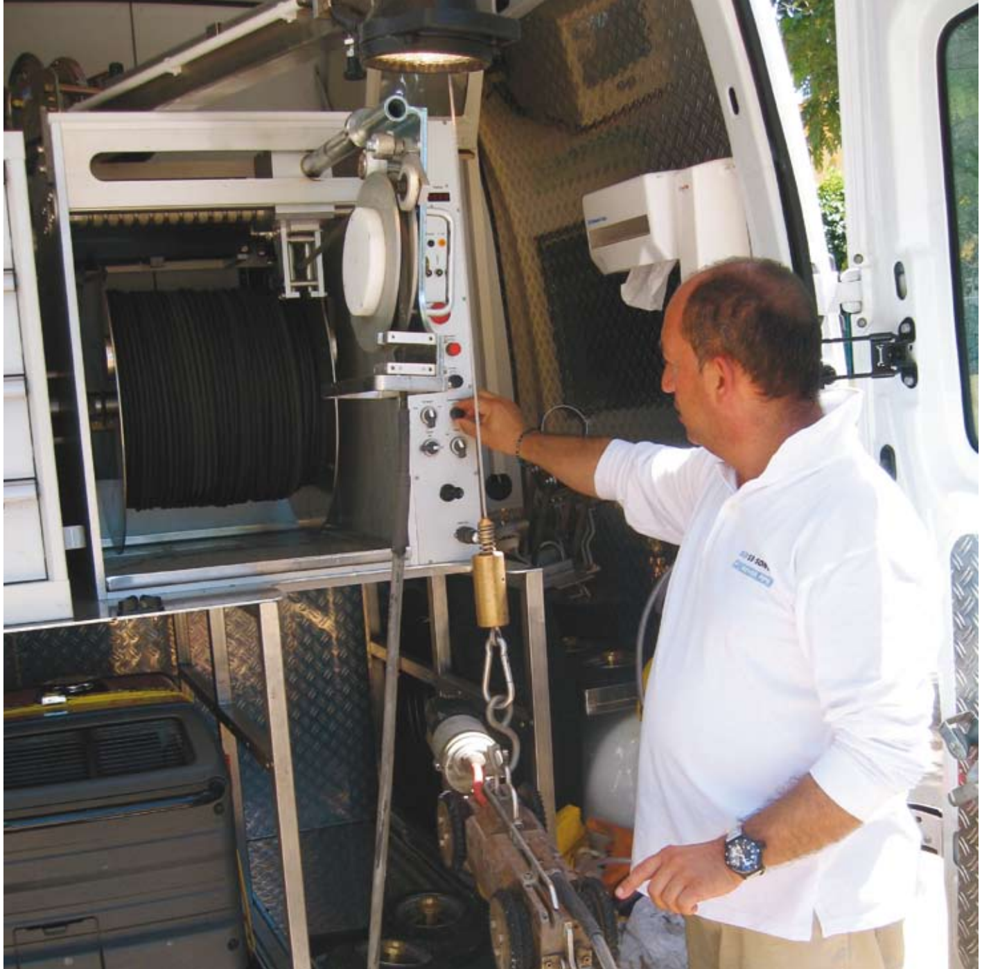
Manuel Pedro Cheia leder jobbet med att gå över vartenda avloppsrör i hela Beira och byta ut eller reparera där det behövs.
