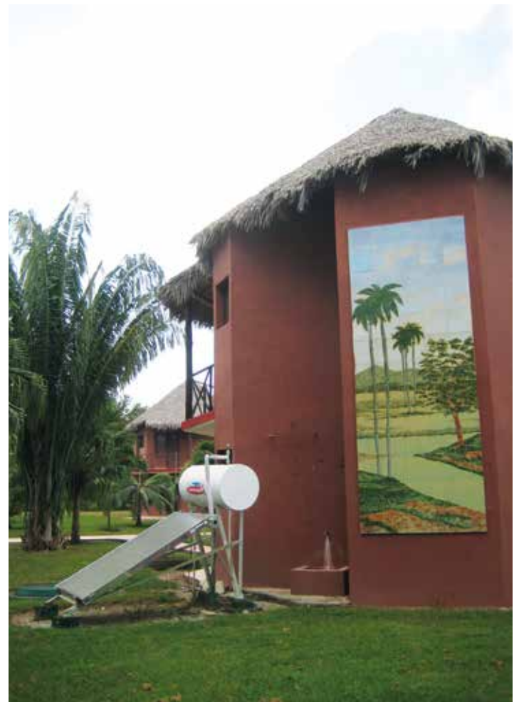
Även inom turismen ökar användningen av förnybar energi, här för uppvärmning av varmvatten i La Granjita, Santa Clara
