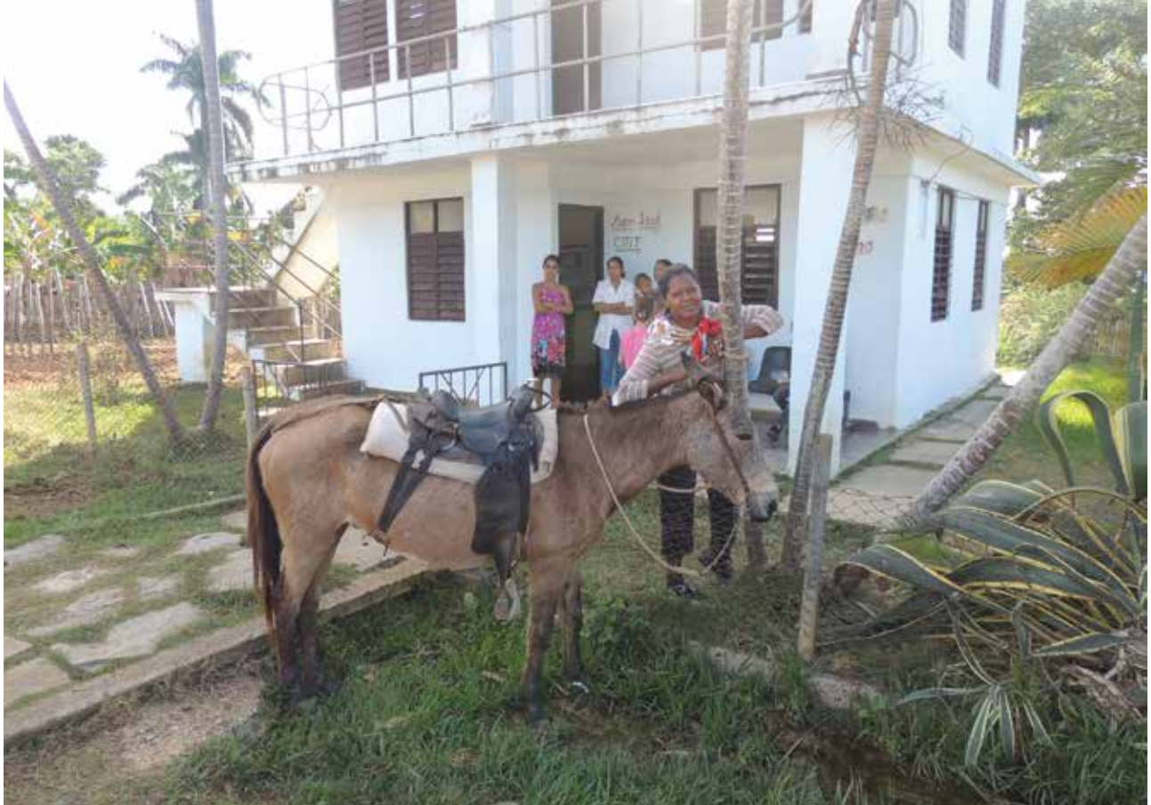
Familjeläkarstationen med mottagning i bottenvåningen och bostad en trappa upp. Hembesök utanför byn görs med häst.
