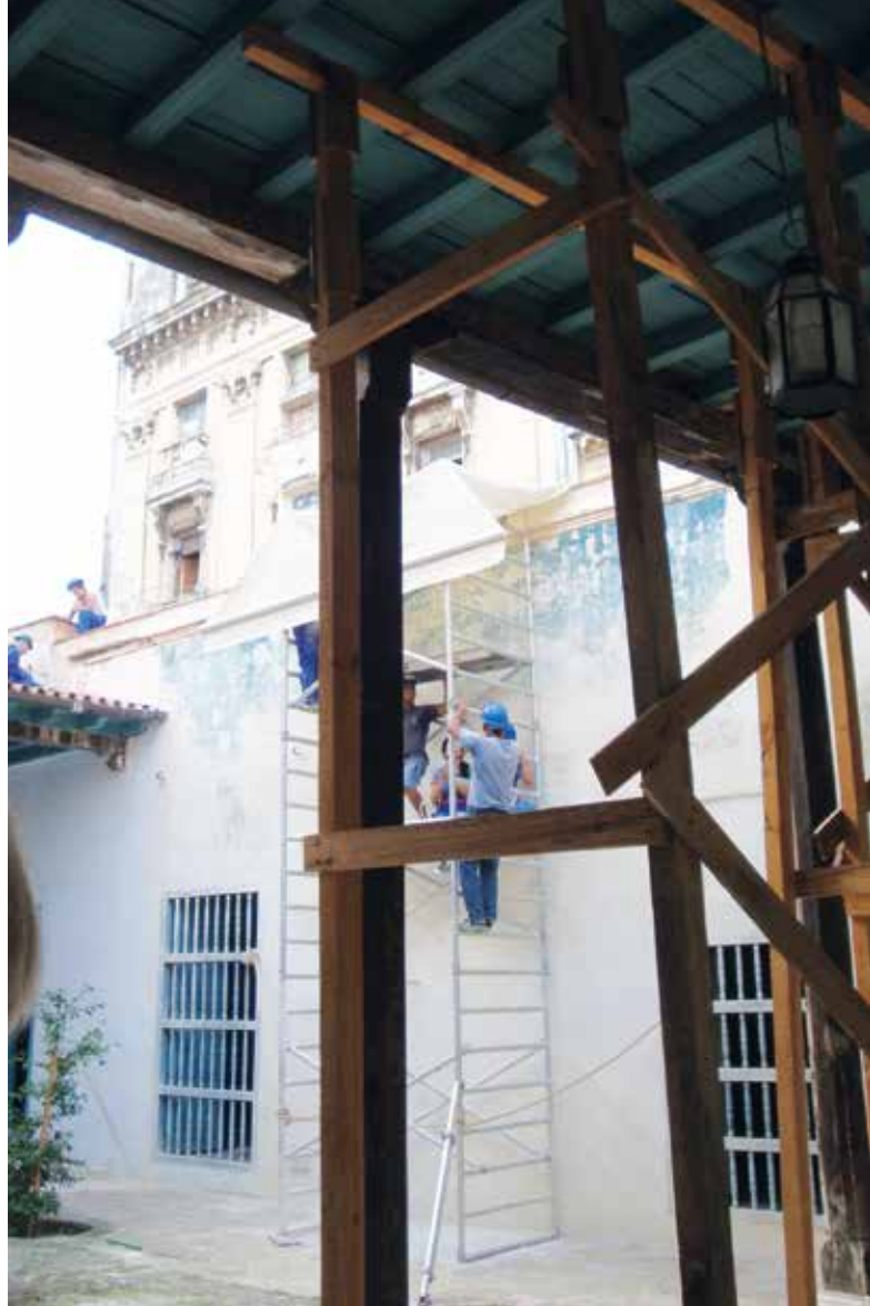
Lager för lager avtäckts den ursprungliga fasadmålningen. Foto Jacqueline Cederström
