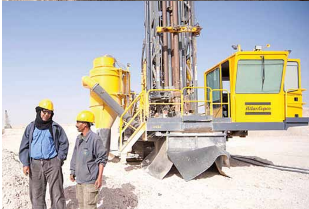
Atlas Copcos borrarutrustning på plats i fosfatgruvan Bou Craa i Västsahara.
