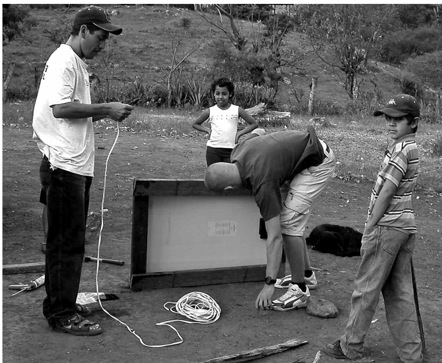
Ungdomspraktikant hjälper till att installera solpaneler i San Nicolás.
