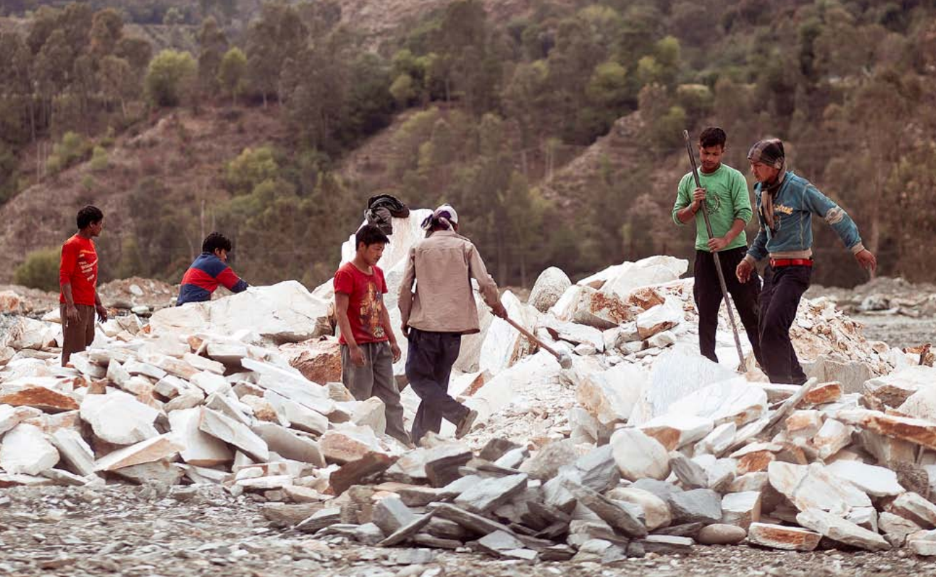
Arbetare som krossar sten till kraftverksbygget i Rampur. Ingen av dem har skyddsutrustning såsom ansiktsmask, skyddsskor och handskar.
