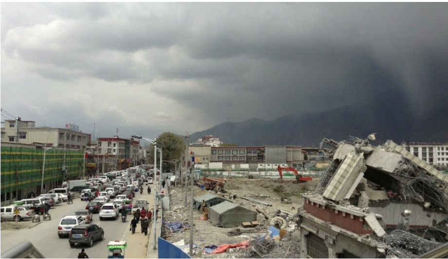
En del av Lhasas gamla stad under pågående rivning.
