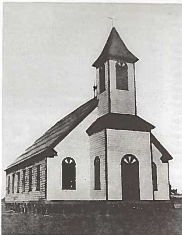
Gudshuset i Bilwaskarma, Nicaragua, byggt av missionär David Haglund. Obs, står på tjärade pälar för att inte bli uppätet av termiter. (Missionen i Bild.)
